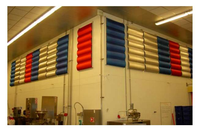
Die gebogenen "Noise Resist" Absorber wurden mit klappbaren Rahmen an die Wand montiert, so dass sie beidseitig mit einem Dampfstrahler gereinigt werden können.
